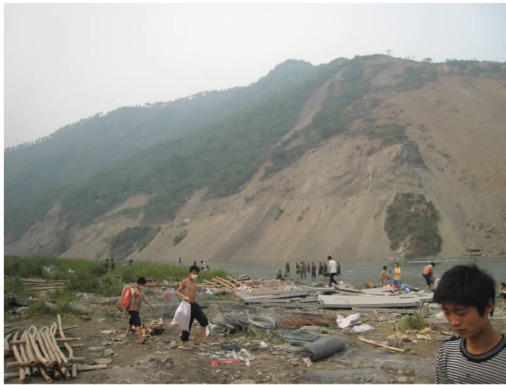
照 13 平武县南坝镇严重的滑坡(镜向:NE)
