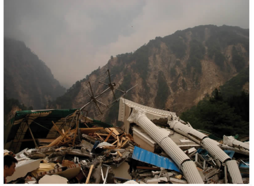
照5 彭州市龙门山镇大龙潭房屋毁坏和山体滑坡(镜向:NE;李亦刚摄)
