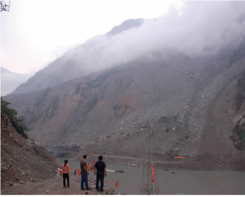
照4 汶川县银杏乡和映秀镇之间巨大连续的滑坡形成了堰塞湖,原来的213国道和省道均不见踪迹(镜向:NE)
