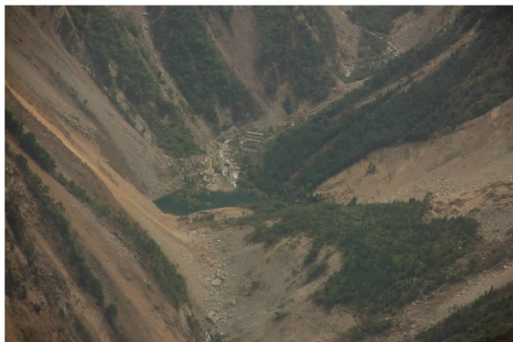
照 3 汶川县银杏乡支沟大规模滑坡(镜向:NW)
