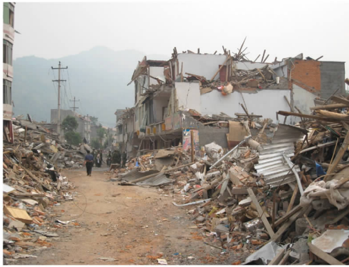
照 12 遭受严重破坏的平武县南坝镇场镇(镜向:W)
