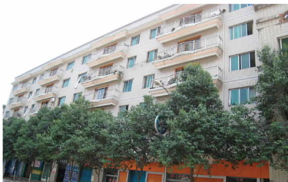
照 8 北川县城内唯一一座外表看上去完整的房子(汶川地震现场考察队摄)
